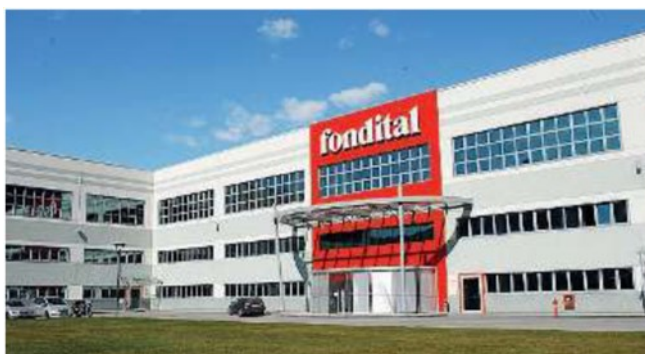
A Carpeneda. Lo stabilimento della Fondital
